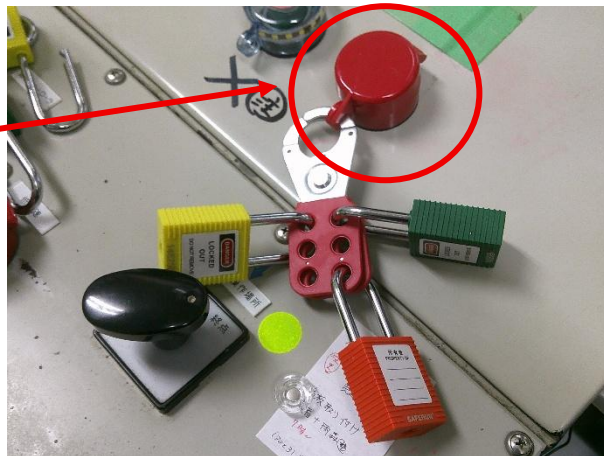
ロックアウトにより誤操作防止
