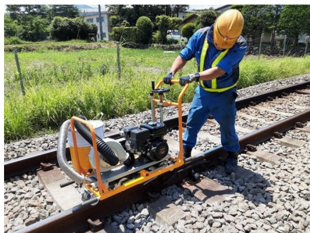
レール継ぎ目段差削正
