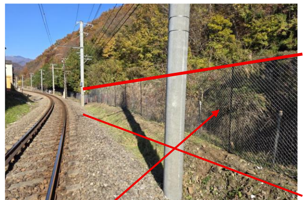
鹿侵入防止フェンス
