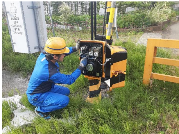
踏切整備・点検
