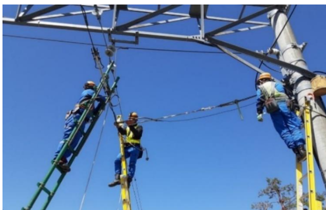
架線の点検・整備
