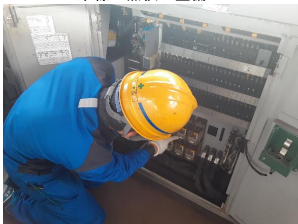
車両の点検・整備
