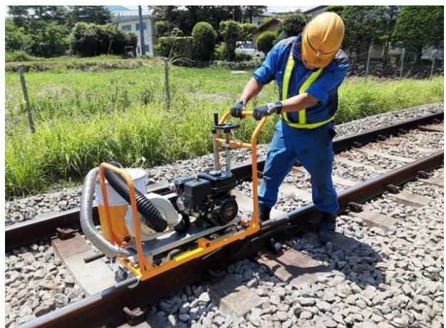
レール削正機導入による継ぎ目段差削正
