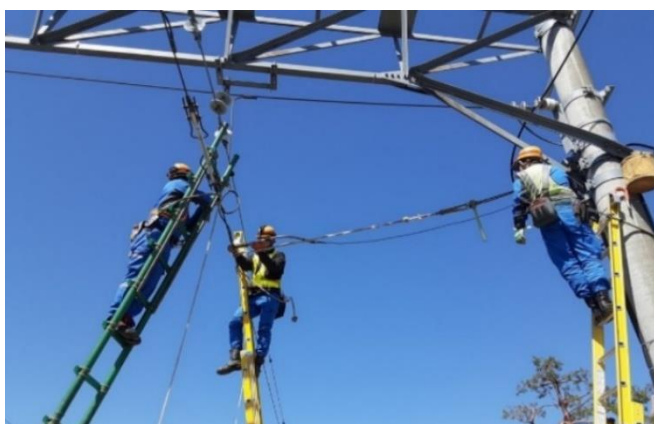
架線の点検・整備
