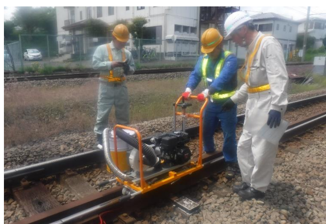
レール削正機導入による継ぎ目段差削正
