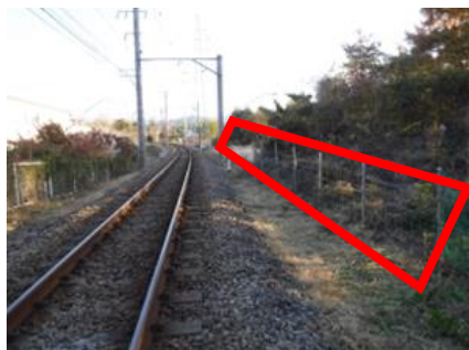
侵入防止柵の延長
